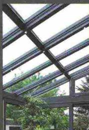
**Le lastre in policarbonato.** Per chiudere senza oscurare, si può optare per questo materiale resistente a urti, gelo e raggi UV. Le lastre di Festa Tende, per esempio, che misurano 6x2 m (a partire da 120 €, montaggio incluso), possono essere trasparenti, fumé, bianco opaco o anti UV.
